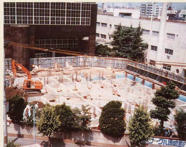
基礎埋戻し工事 (60年7月) 鉄骨が組みまれ(下) 60年7月、 着々と進む建設工事(左) 60年10月
