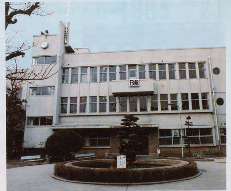
解体前のB館(旧本館)
