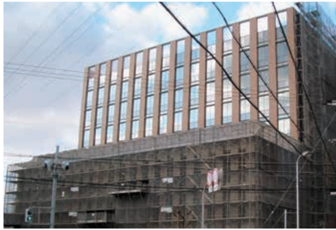
南側から見たJ館(新事務・研究棟)
