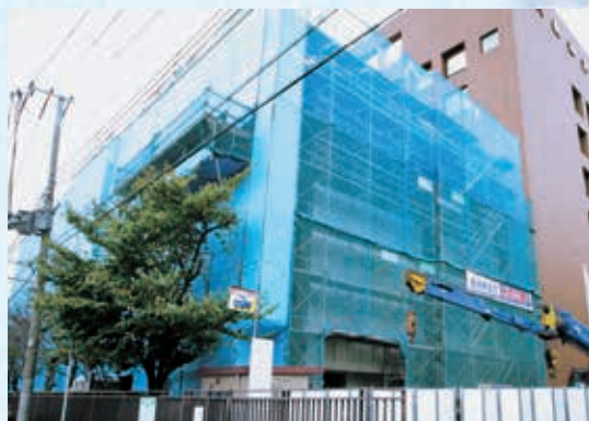
建設中の新図書館
